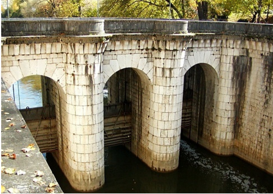
Le paratie sul canale collettore centrale, all'Incile, prima dell'ingresso all'emissario in galleria
